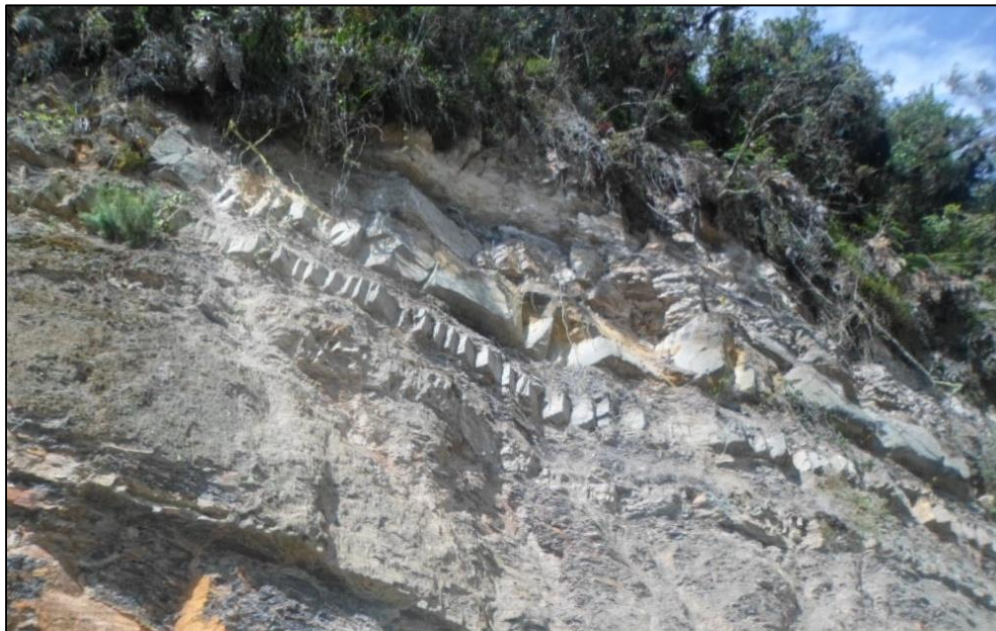
Figura 3.13. Ladera de contrapendiente, tomada desde; 1014874 E, 996244 N, H: 2584 m. Fuente: Presente Estudio
